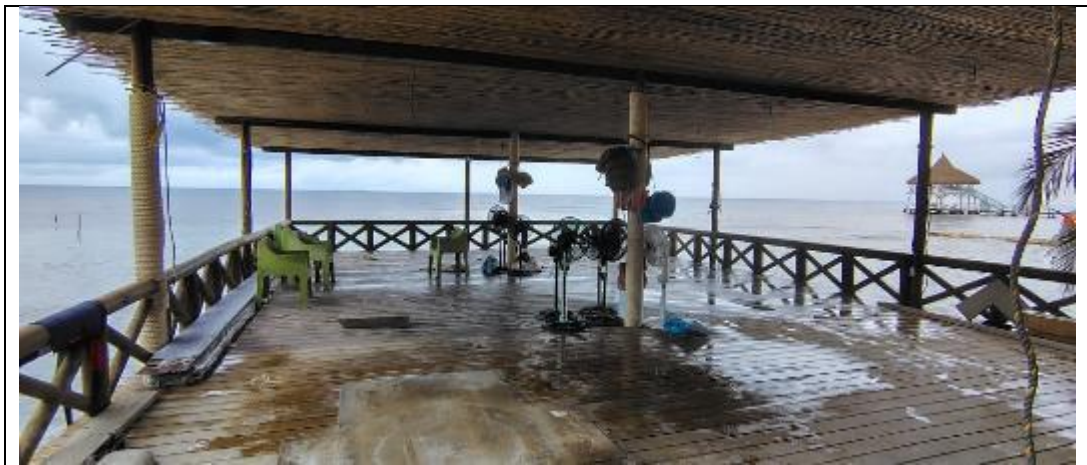
Fotografía 7 Plataforma en madera, estructura evidenciada en la visita de seguimiento del 9/10/2025
