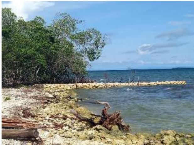
Fotografía 2 Espolón No. 2. Estructura evidenciada en el informe de campo del 13 de septiembre de 2021
