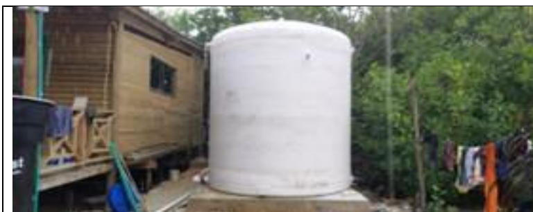
Fotografía 16 Placa en concreto, evidenciada en visita de campo 9/10/2025
