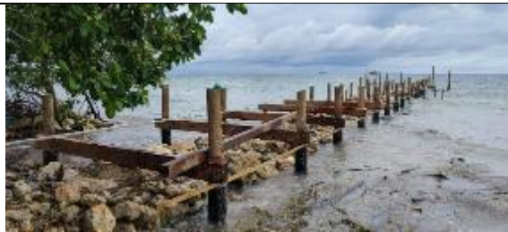
Fotografía 4 Espolón No. 2 continua en construcción. Verificado en visita de campo del 9/10/2025
