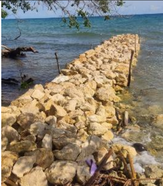
Fotografía 1 Espolón No. 1. Estructura evidenciada en el informe de campo del 13 de septiembre de 2021
