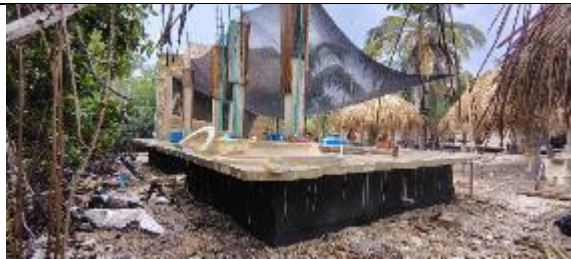
Fotografía 11 Estructuras plataformas para jacuzzi. Verificado en visita de campo del 9/10/2025
