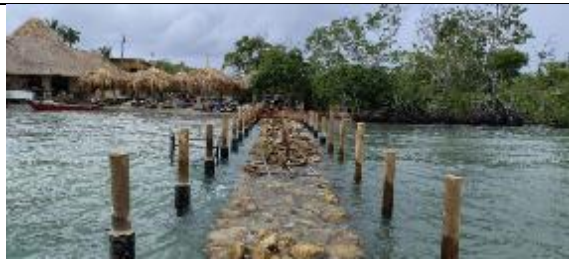
Fotografía 3 Espolón No. 1 continua en construcción. Verificado en visita de campo del 9/10/2025
