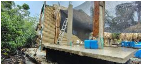
Fotografía 10 Estructuras plataformas para jacuzzi. Verificado en visita de campo del 9/10/2025
