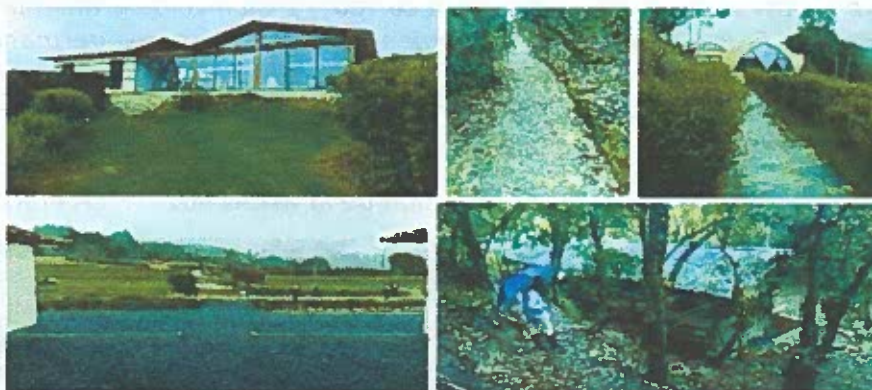
Imagen 7. Zona de uso intensivo e infraestructura de la RNSC 002-17 LA PERIQUERA. Fuente: Visita técnica PNNC.
