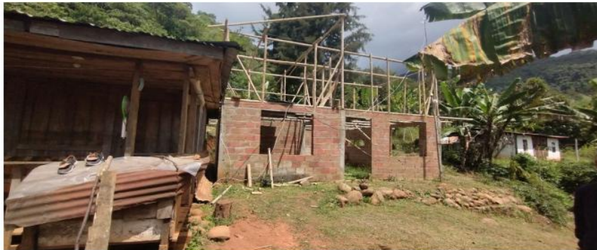
12/07/2024 infraestructura encontrada con guadua con forma de segundo piso para soporte de techo
