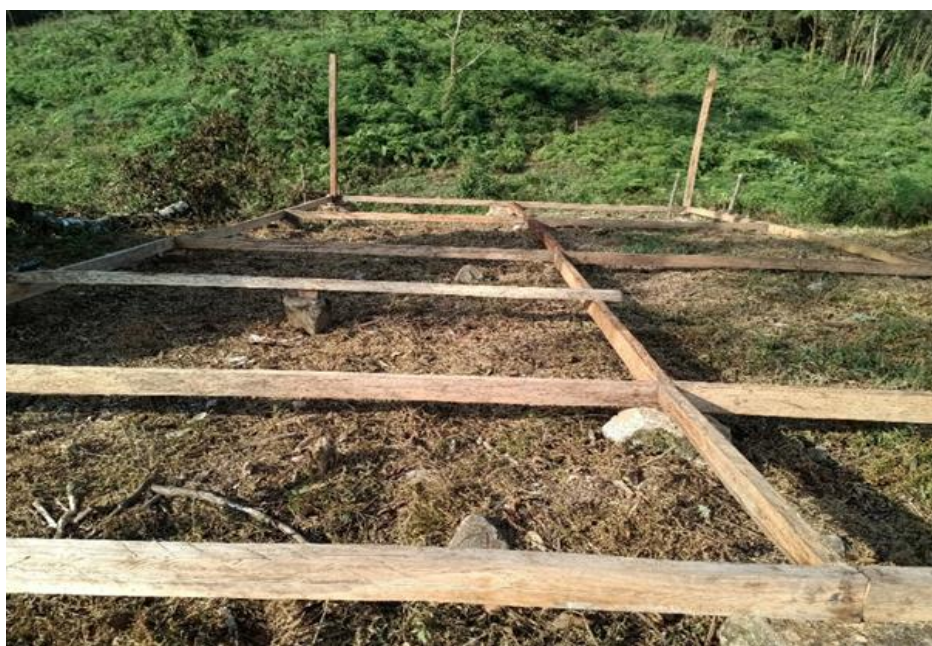
Figura 8. Cimientos de madera de nueva edificación registrada en la visita. 04-02-2026
