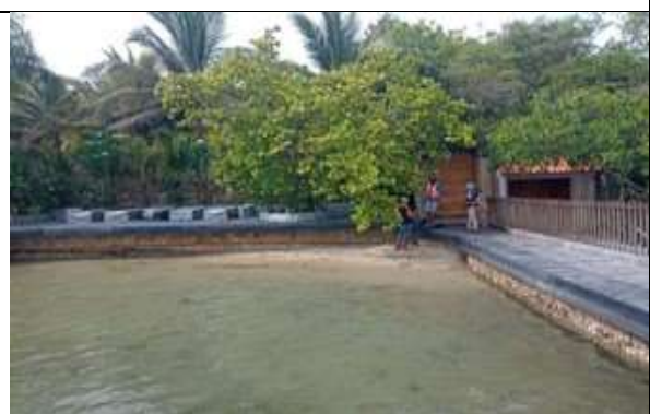
Foto 4. Medición plataforma muelle-espolón.05-06-22025.
