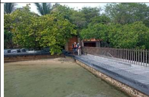
Foto 3. Medición de plataforma largo espolón-muelle.
