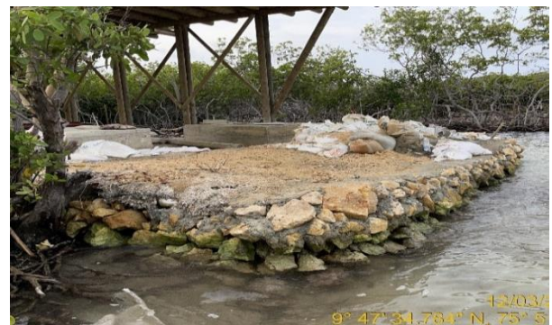
Fotografía No. 4 Área posterior de la estructura – Muro y relleno de piedra y arena. Fuente: Del informe de campo PNNCRSB, 2025.
