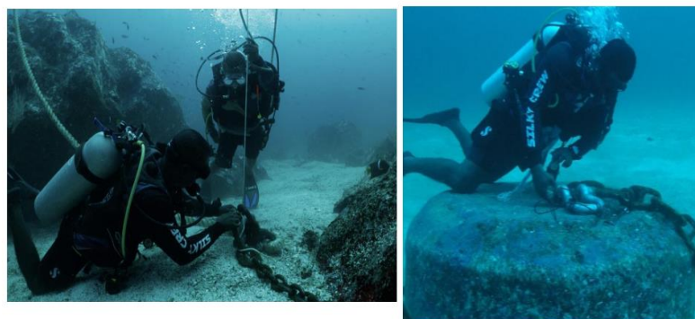
Ilustración 15 Maniobras para el diagnóstico y mantenimiento en los puntos de amarre
