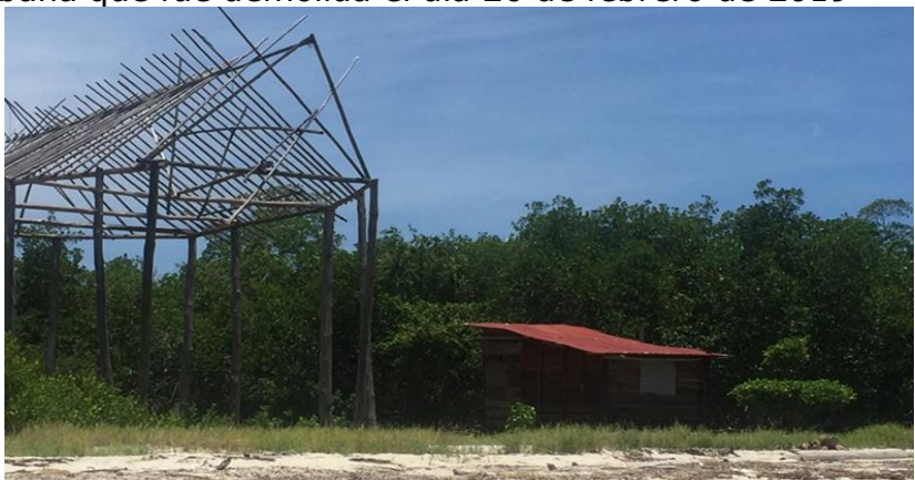
Vista de la nueva estructura construida con el material producto de la demolición realizada el 20 de febrero de 2019
