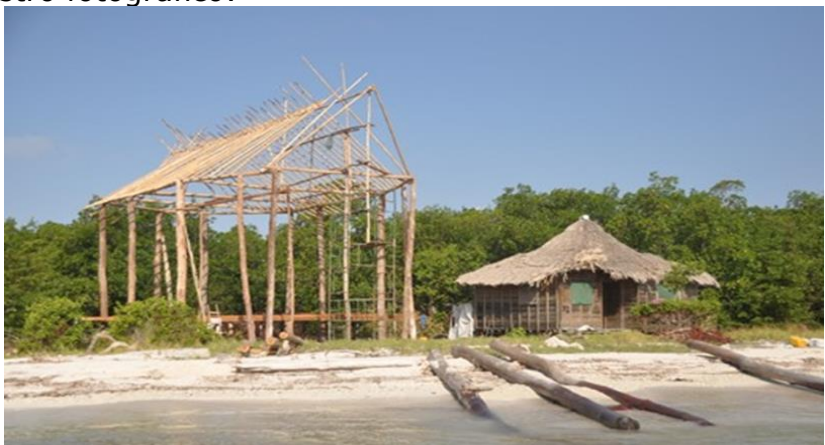
Vista de la cabaña que fue demolida el día 20 de febrero de 2019
