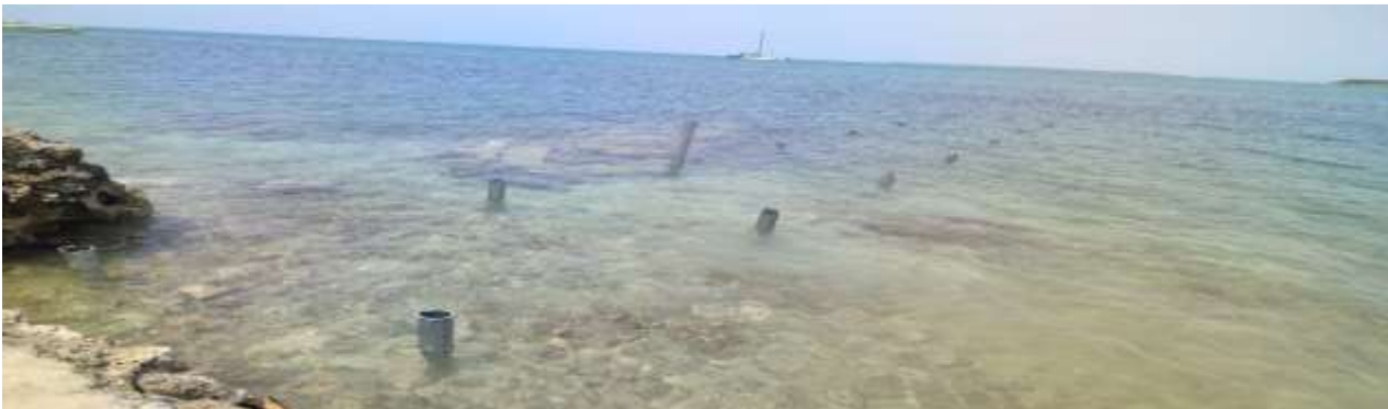
Imagen 1: infraestructura encontrada el día 18 de abril del 2024
