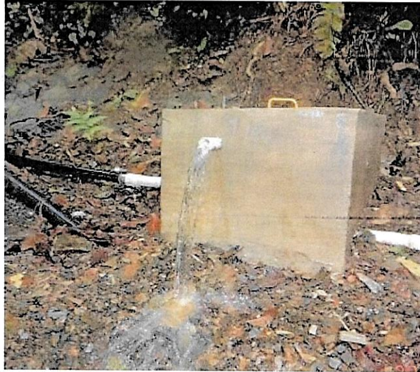
Tomado de: Diapositiva 1. EPSA- Adecuaciones Infraestructura Acueductos Bajo Anchicayá
