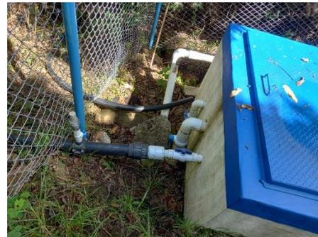
Tubo galvanizado de 3 pulgadas y manguera de polietileno de 2 pulgadas sin conectar (12-02-2025)
