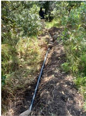
Manguera de polietileno de 2 pulgadas enterrada de forma provisional para conducir agua hasta la red principal de Asochaina (12-02-2025)
