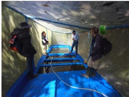
Piscinas que filtran los sedimentos del tanque desarenador (12-02-2025)
