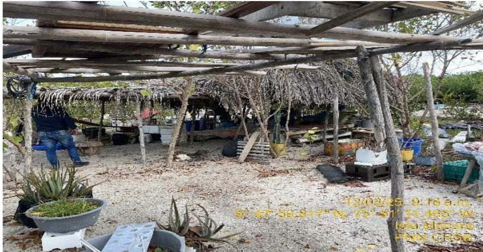
**Fotografía No. 6** Currancha (Choza) construida con troncos de madera, techo en palma, con piso en arena de playa. *Fuente: Del informe de campo PNN CRSB, 2025.*
