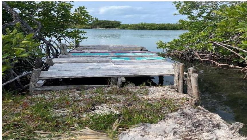
**Fotografía No. 8** Estructura tipo muelle elaborado en tabla y pilotes en troncos de madera, con medidas de 5 metros de largo por 1,5 metros de ancho aproximadamente. *Fuente: Del informe de campo, PNN CRSB, 2025.*
