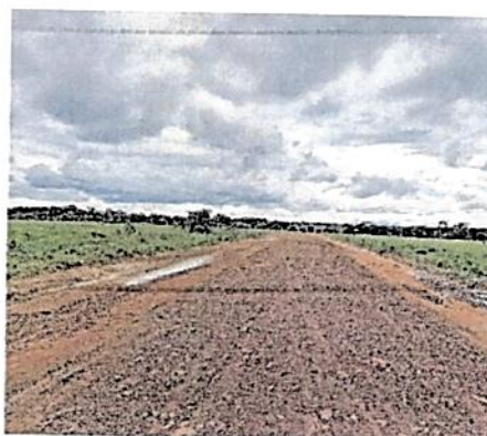
Fotografía 40 Trazado actual de Ruta Nacional 38 en terraplén no pavimentado
