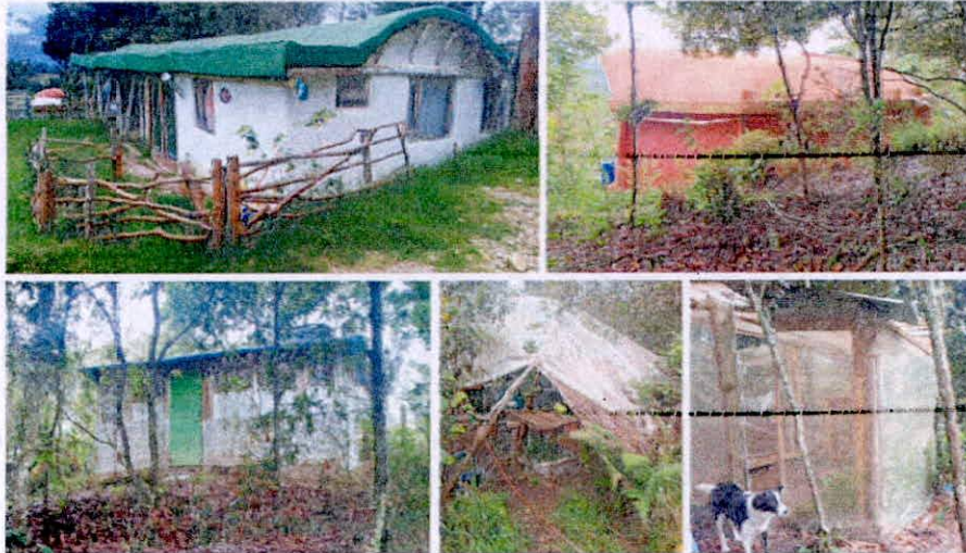
Imagen 6. Zona de uso intensivo e infraestructura de la RNSC 040-13 COCHAHUAIIRA. Fuente: Visita técnica.
