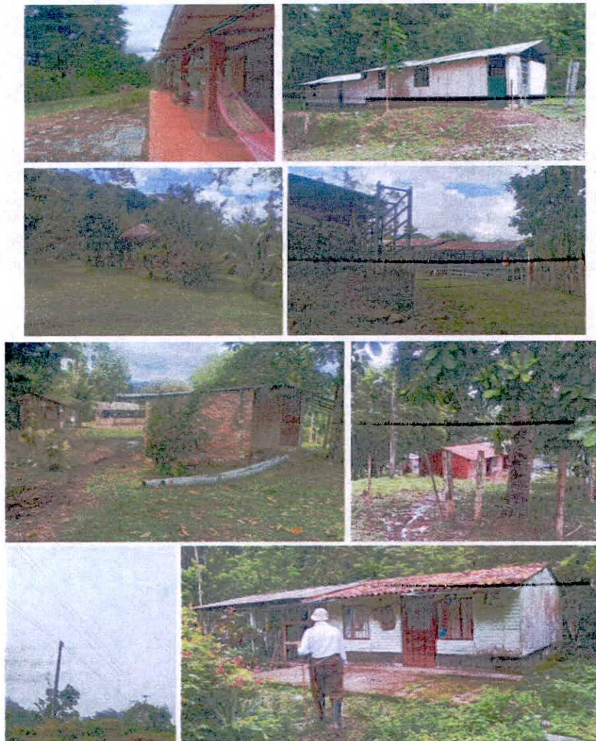
Imagen 3. Zona de uso intensivo e infraestructura de la RNSC 117-08 LA ZAMBERA. Fuente: Visita técnica de seguimiento.
