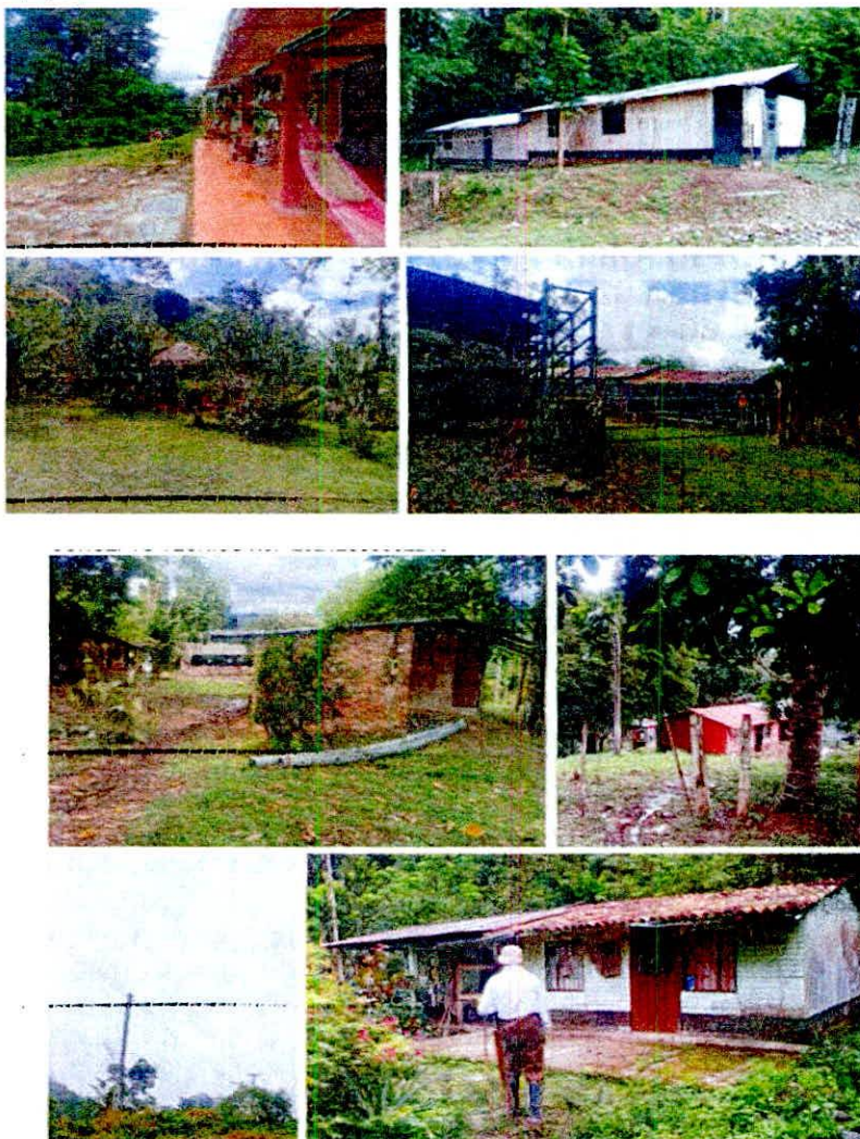
Imagen 14. Zona de uso intensivo e infraestructura de la RNSC 117-08 LA ZAMBERA. Fuente: Visita técnica de seguimiento.
