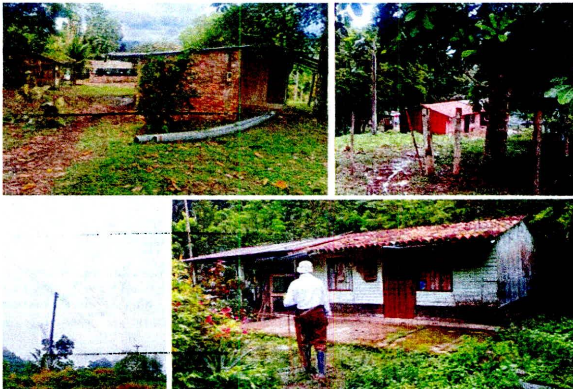
Imagen 3. Zona de uso intensivo e infraestructura de la RNSC 117-08 LA ZAMBERA. Fuente: Visita técnica de seguimiento.
