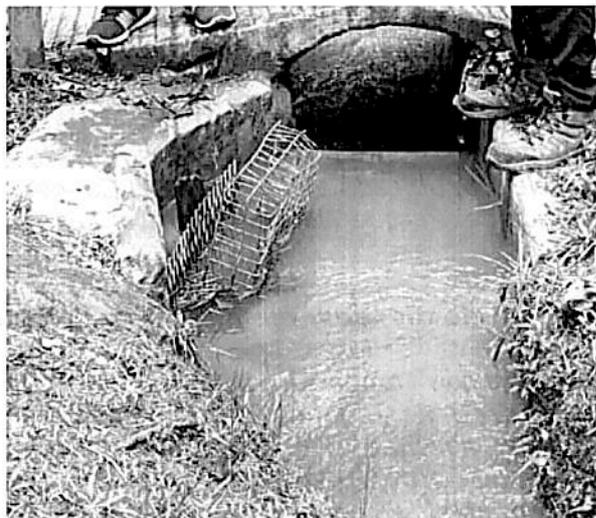
*Captación mediante tubería instalada en margen izquierda del canal*
