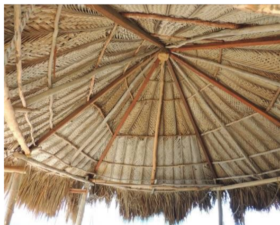
Figura 12 B. Parte interna del techo del kiosco en madera y palma
