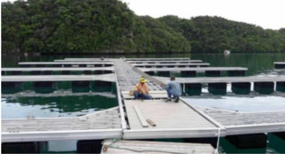
**Figura 1.10 Fotografía de armado de un muelle Flotante**
