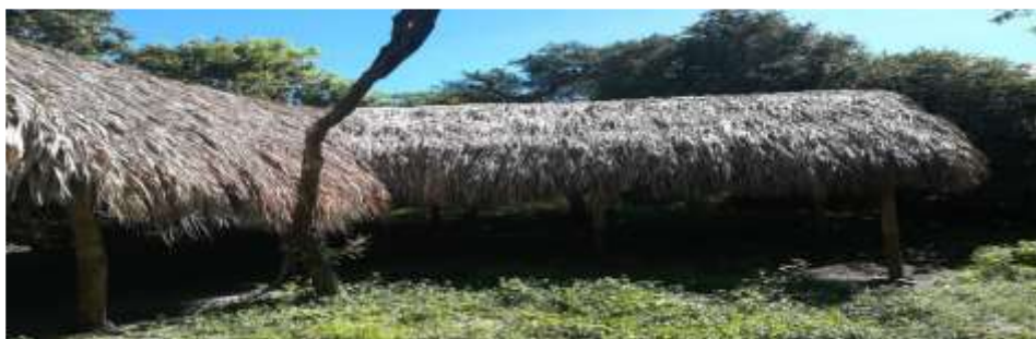
Fotografía 1. Infraestructura hecha en madera y techo de palma. Exp 004/2022
