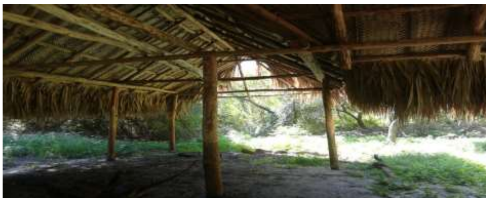
Fotografía 2. Vista interna Infraestructura hecha en madera y techo de palma. Exp 004/2022
