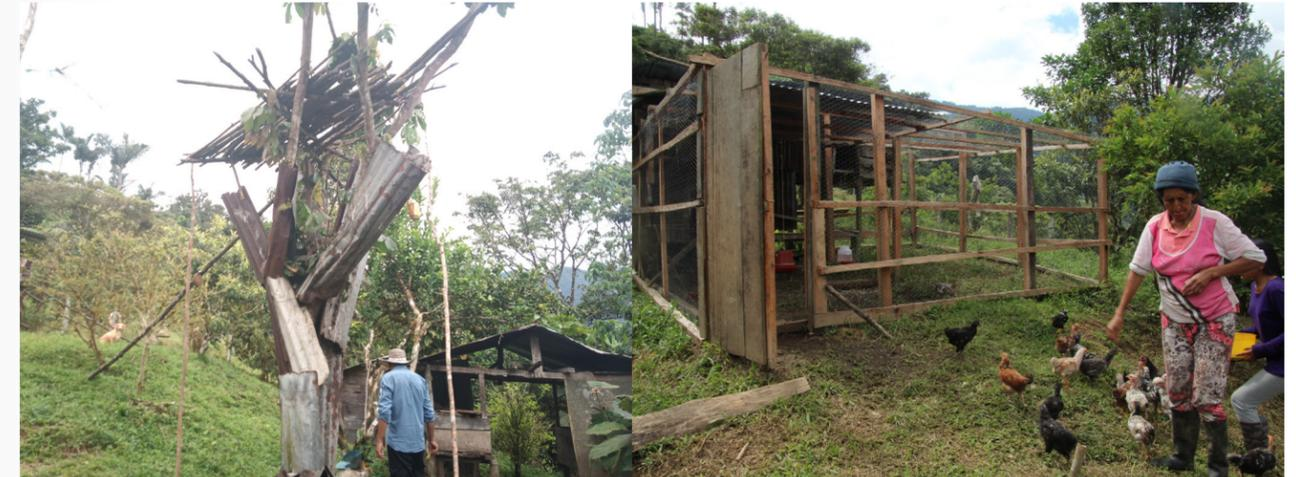
En la Figura 8 se observa a la izquierda el gallinero antes de la acción de manejo con láminas de zinc para impedir el acceso de depredadores, especialmente de puma, a la derecha se muestra el corral construido y la dueña del predio.
