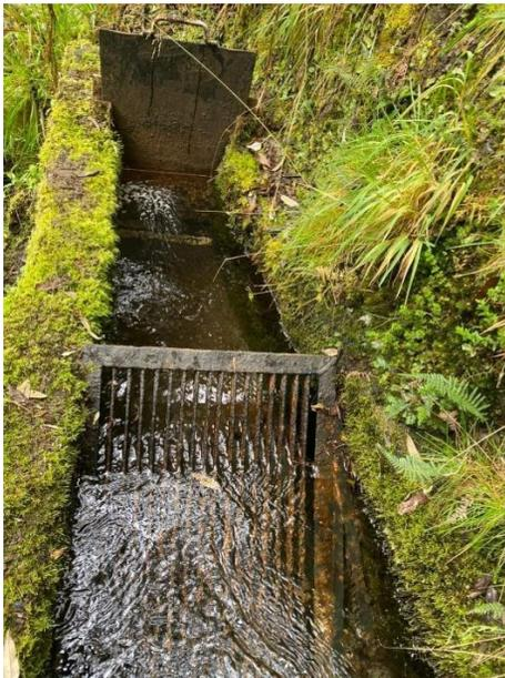
Figura 3. Acequia, bocatoma y compuerta de control
