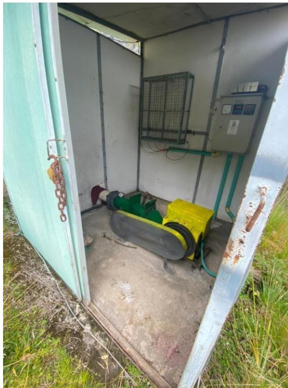
Figura 5. Cuarto de Máquinas -Turbina Pelton
