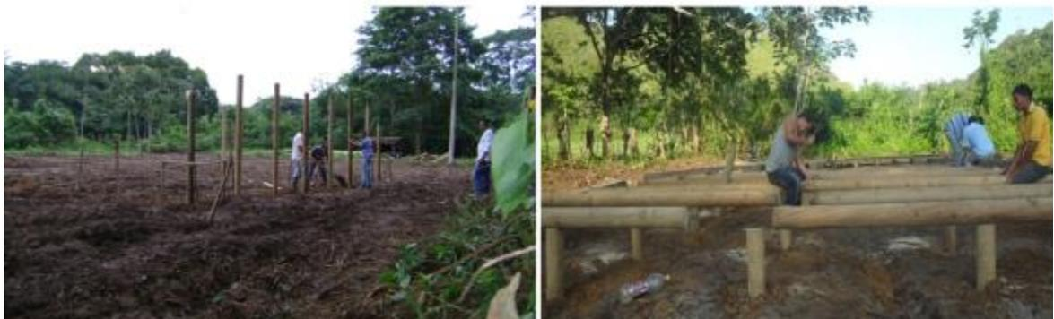
**Fotografía N° 7** Detalle de los trabajos de hincado de pilotes para la construcción del Centro de Interpretación y oficinas administrativas. Obsérvese la explanación y limpieza preliminar que ya se había
