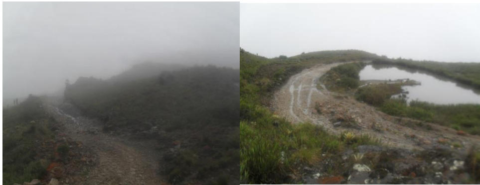
Foto 2. Tramo de vía en sitio llamado laguna del Billar (Izquierda) y Laguna afectada en el sitio Peña Negra (derecha)
