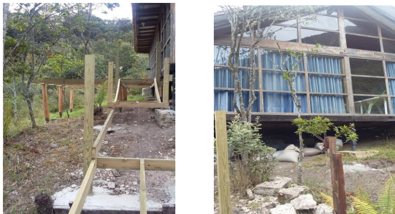
Foto: Arreglos al Auditorio. – Fuente: Autor
